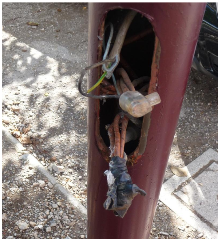
Fig. 22 – Giunzioni fatiscenti e collegamento a terra tranciato su uno dei pali di fronte alla centrale termica della scuola elementare di Stenico
