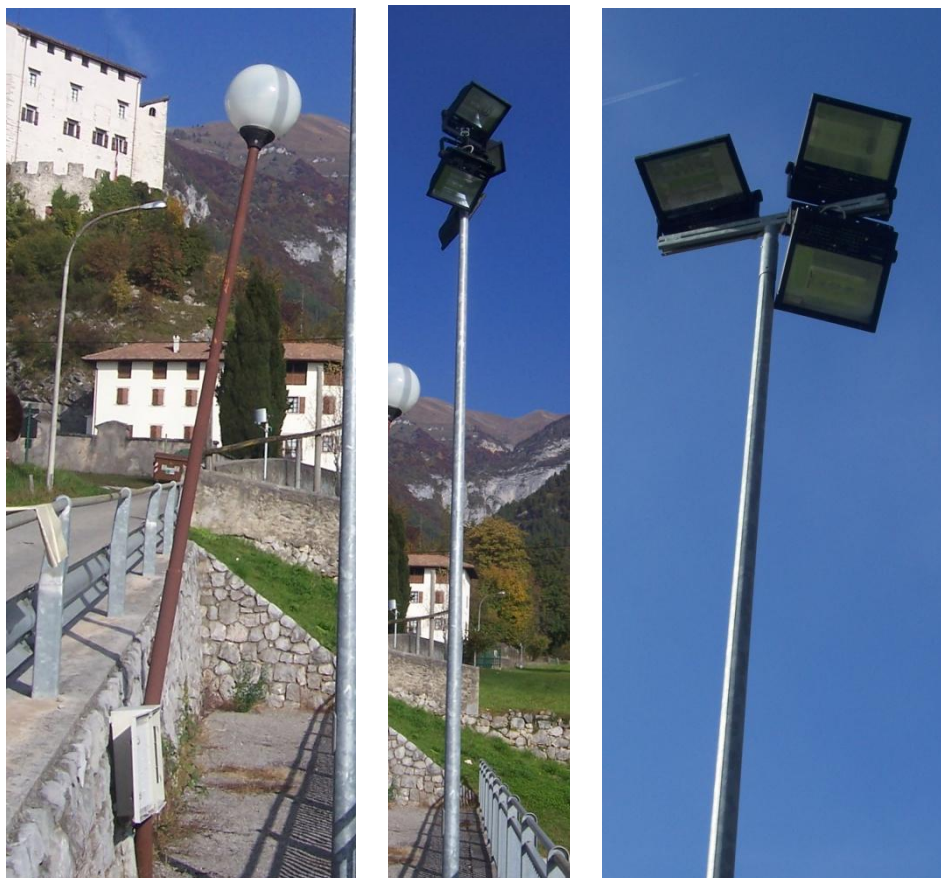
Fig. 55 – Tipologie di corpi illuminanti utilizzati per l'illuminazione del campo sportivo: punto luce del tipo a globo (a sinistra), punto luce con 4 fari (al centro) e punto luce con 3 fari (a destra)
