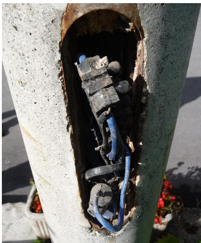
Fig. 24 – Altro esempio di collegamenti fatiscenti
