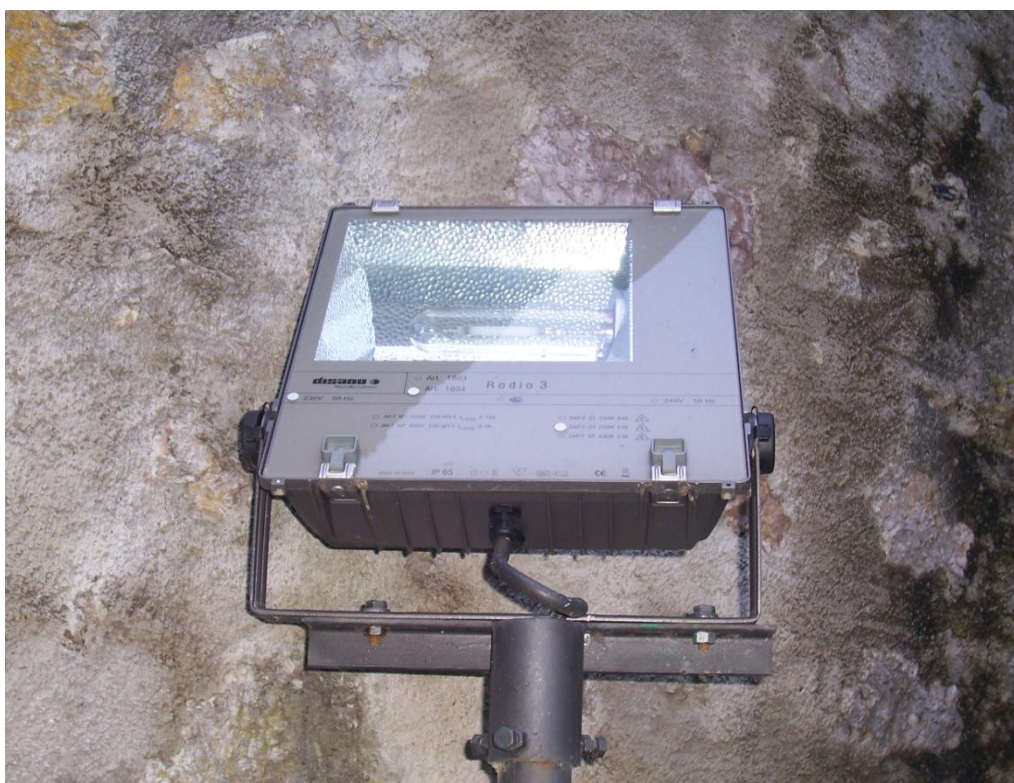
Fig. 83 – Fari installati per l'illuminazione delle facciate del Castello di Stenico che montano lampade ai vapori di sodio della potenza di 250 W
