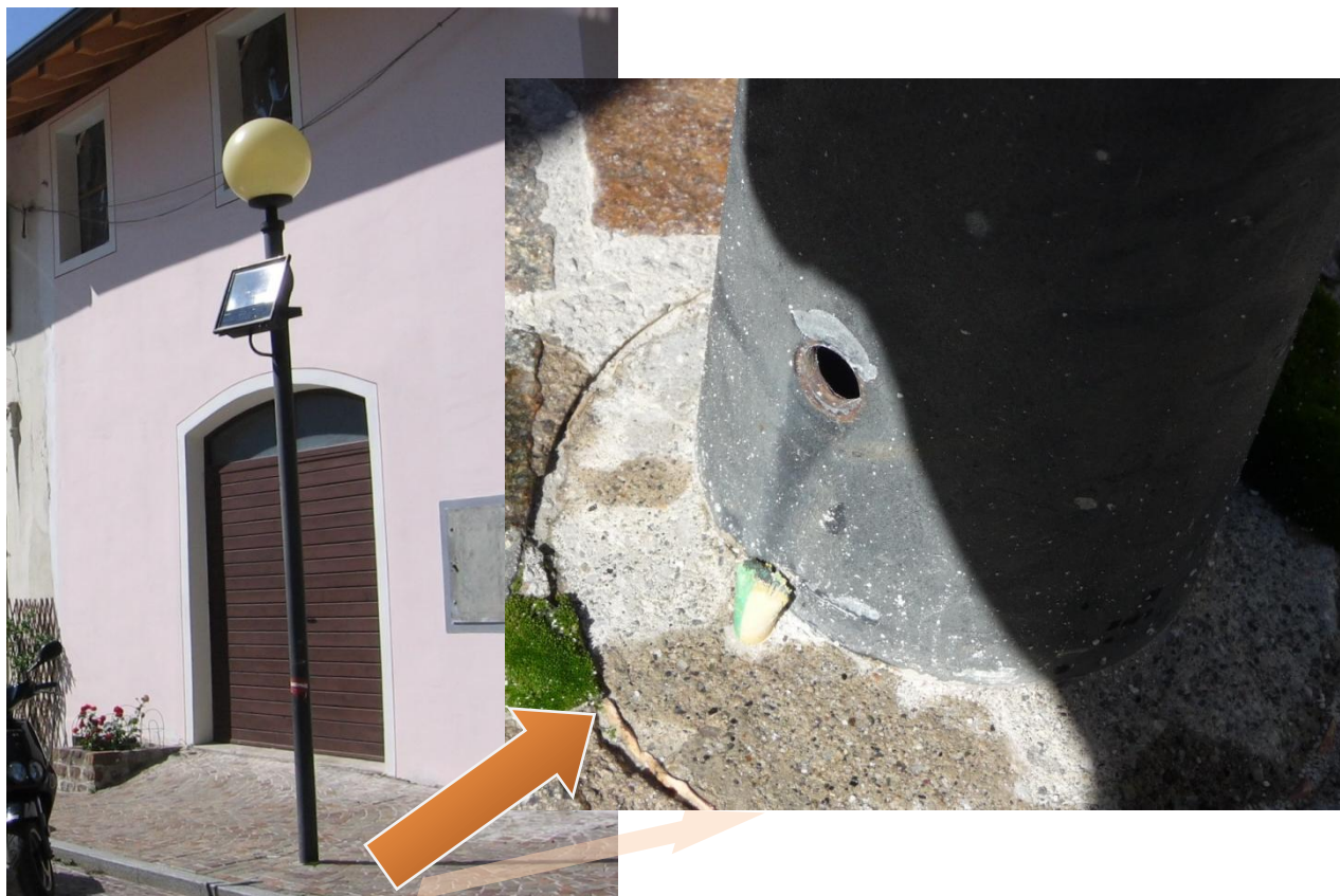
Fig. 19 – Collegamento di messa a terra reciso in uno dei pali di Viale Brigata Torino, di fronte al quadro elettrico
