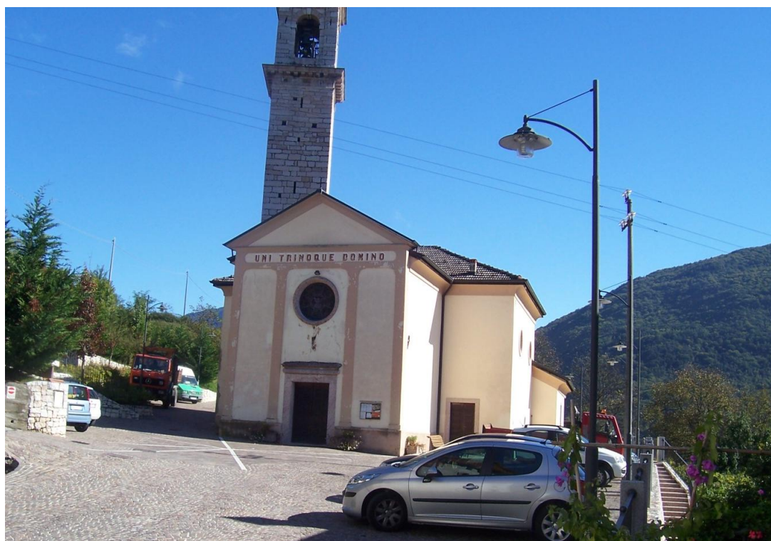
Fig.63 – Punti luce del tipo con sbraccio con installate lampade agli ioduri metallici della potenza di 70 W
