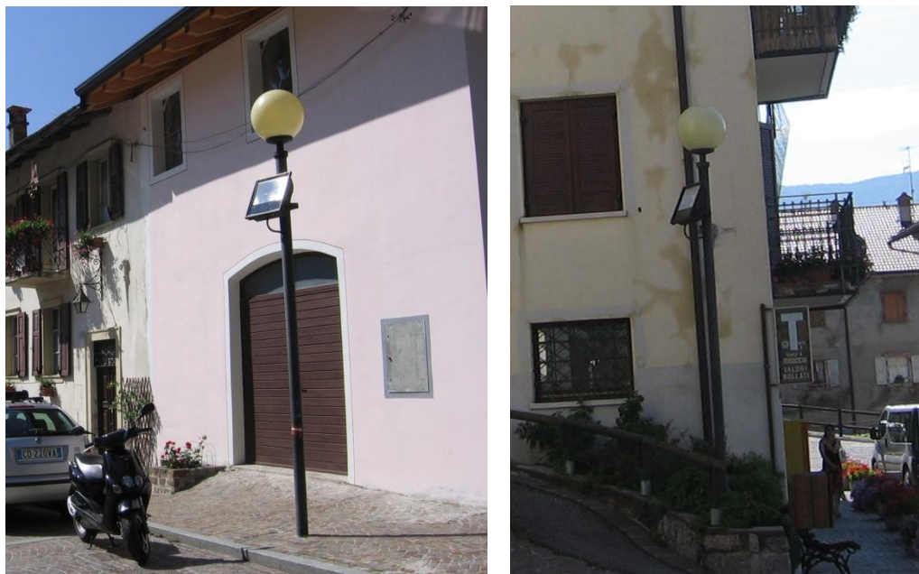
Fig. 57 – Fari ai vapori di sodio della potenza di 250 W montati sui 2 punti luce presenti di fronte alla chiesa
