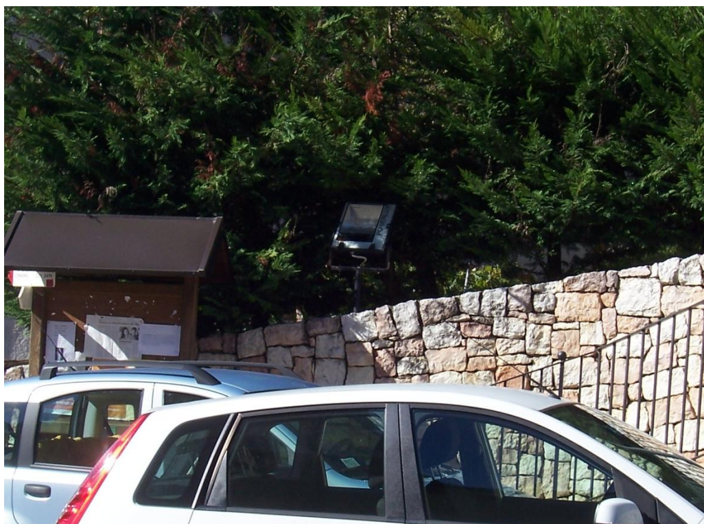
Fig. 62 – Faro ai vapori di sodio della potenza di 250 W installato in prossimità della chiesa di Villa Banale
