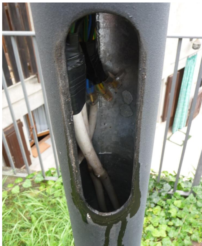
Fig. 20 – Problemi di infiltrazione in uno dei pali del parcheggio di fronte al Municipio, dovuto al posizionamento errato di una guarnizione (l'acqua è stata evacuata in fase di sopralluogo)
