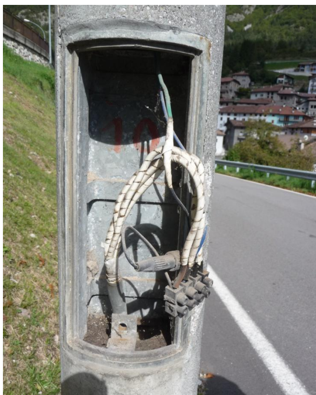
Fig. 23 – Altro esempio di collegamenti fatiscenti
