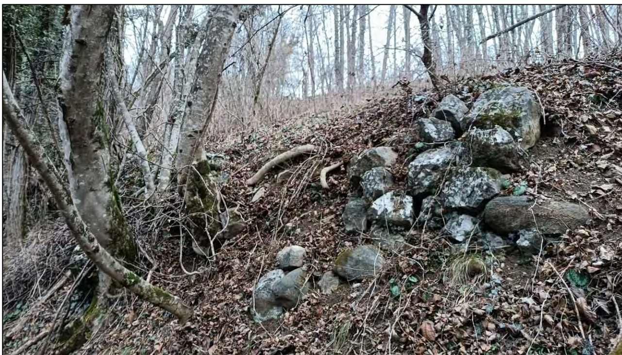
DETTAGLIO MURETTI A SECCO A MONTE DELL'AREA DI INTERESSE. LE STRUTTURE SI PRESENTANO COMPLETAMENTE DISARTICOLATE DALLA VAGETAZIONE CHE NE HA COMPROMESSO DEFINITIVAMENTE LA LORO FUNZIONE
