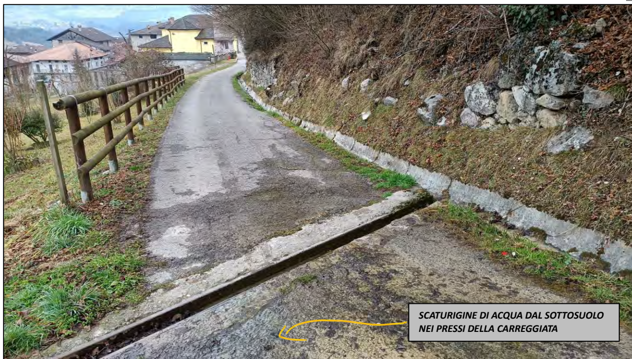
Figura 10. Sistema di regimazione delle acque meteoriche nell'area di interesse
