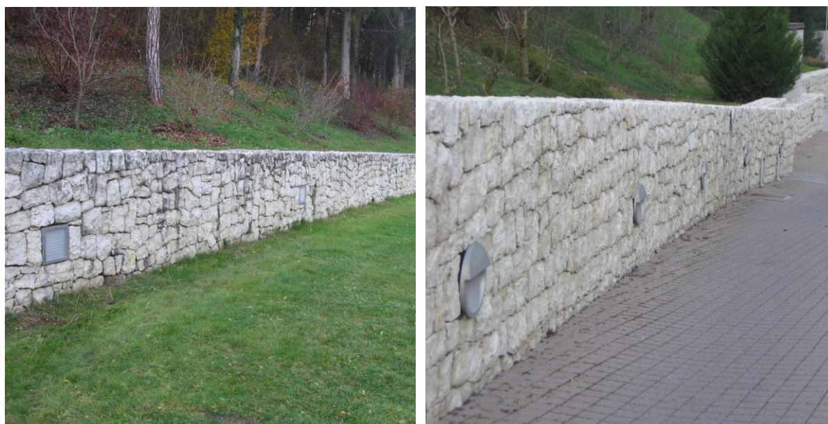
Fig. 15 – Corpi illuminanti con tubi fluorescenti utilizzati per l’illuminazione del parcheggio (a sinistra) e della stradina sul retro del Grand Hotel Terme.
